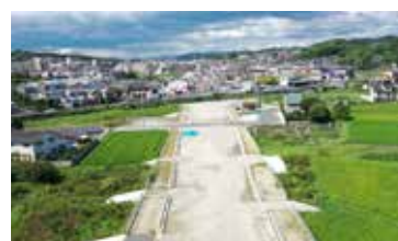
小瀬町付近(1工区)の状況
