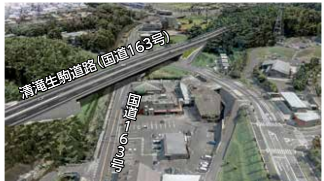
■鹿畑地区鹿畑町高架橋(仮称)(右図②)
